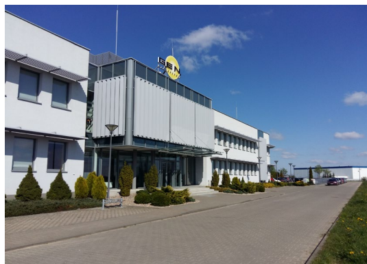
Rys. 3. Biurowiec G.EN. Gaz Energia w Tarnowie Podgórnym
