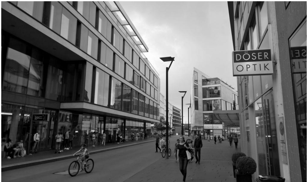
Rys. 9. Ulm – „Neue Mitte”, ulica dla autobusów [fot. Autor]
