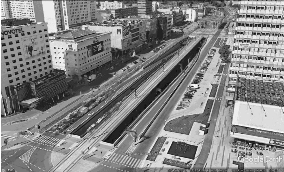
Rys. 20. Łódź – Trasa WZ. Model trójwymiarowy pokazujący szczeliny wentylacyjne pasów szybkich trasy i rampy łączące. Daleko w głębi dach nad węzłem tramwajowym. Przejścia naziemne zastąpiły tunele dla pieszych [Google Earth]
