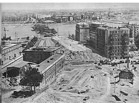
Rys. 4. Budowa Mostu Śląsko-Dąbrowskiego i trasy W-Z [Małcużyński 1955]
