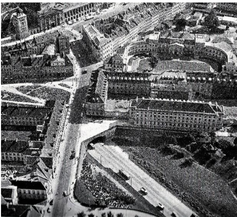
Rys. 6. Widok na zachodni wylot tunelu Trasy W-Z [Ciborowski 1964]
