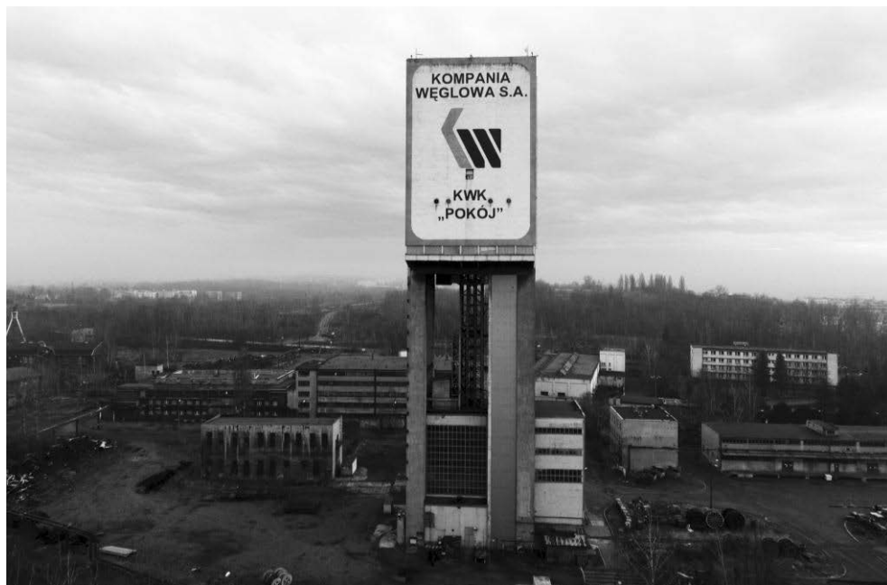
Rys. 2. Górująca nad terenem wieża nadszybia szybu Wanda [Stangel 2021]
