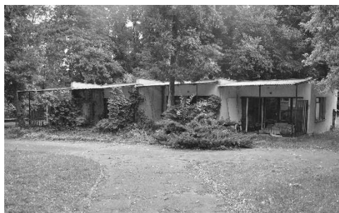
Rys. 7. Kiekrz, ośrodek wybudowany dla Akademii Rolniczej w Poznaniu zlokalizowany nad Jeziorem Kierskim, oryginalne domki szeregowo – stan przed remontem [fot. J. Bogajewska-Danek, 2021]
