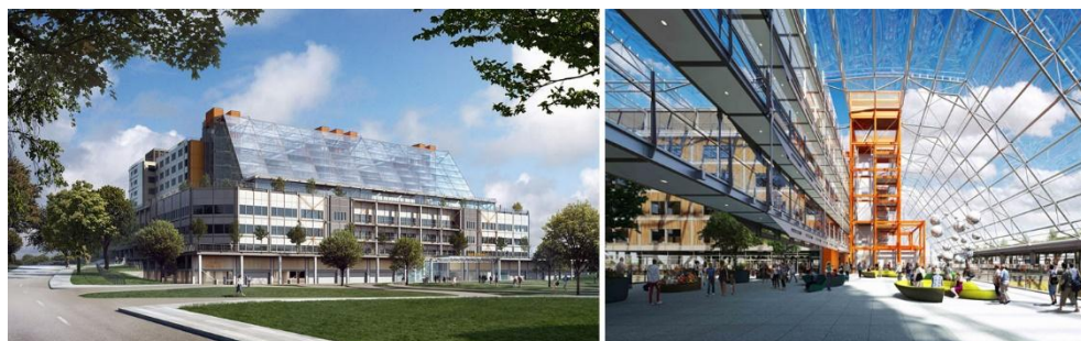
Rys. 6. Midland Metropolitan University Hospital, Sandwell, UK (Edward Williams Architects). Widok ogólny budynku oraz wnętrza strefy wejściowej
