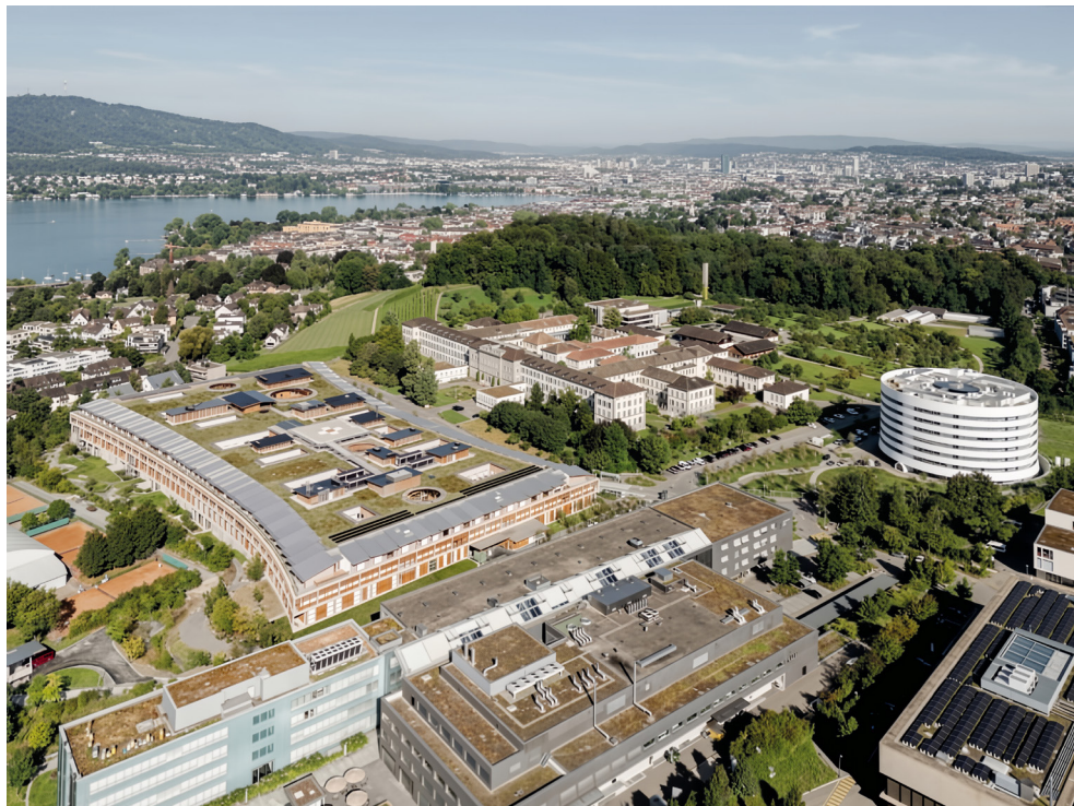
Rys. 8. Szpital Dziecięcy na przedmieściach Zurichu. Widok od szpitala radiologicznego na nowo wybudowany dziecięcy oraz psychiatryczny z początku XX w. [Architektura i Biznes 2025b]
