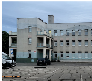
Rys. 7. Widok na budynek ośrodka, w którym funkcjonuje hostel [P. Otto]
