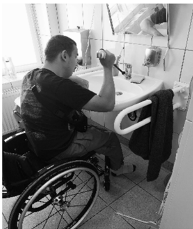
Rys.11. Łazienka, bateria z wyciąganą główką
