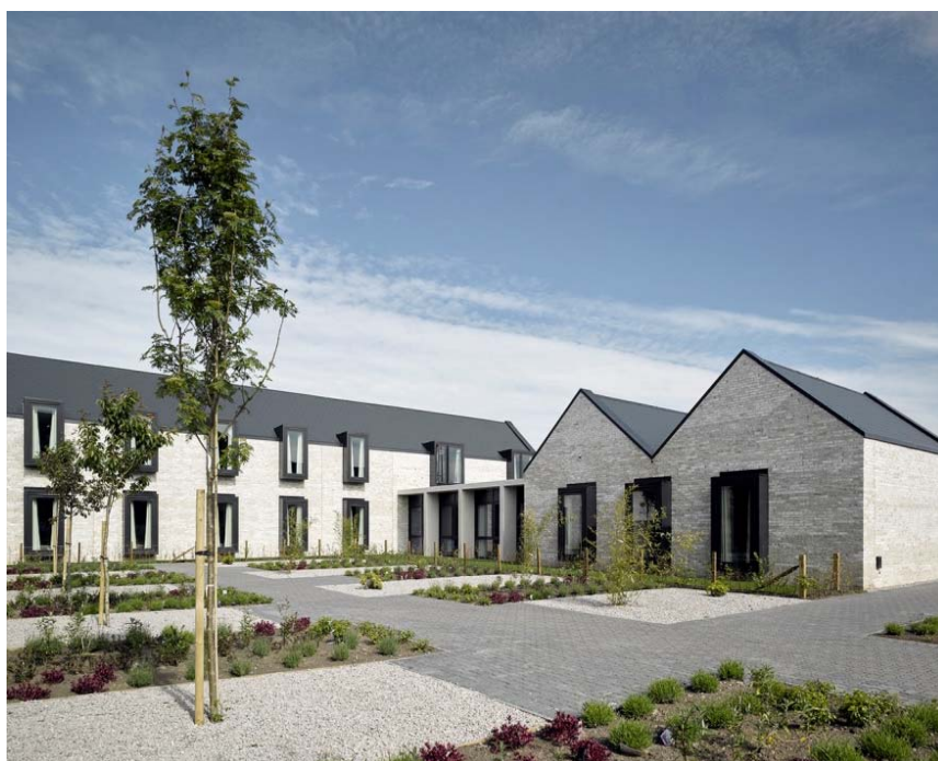
Rys. 5. Ronald McDonald House w Glasgow (proj. Keppie) (archdaily.com 2015)
