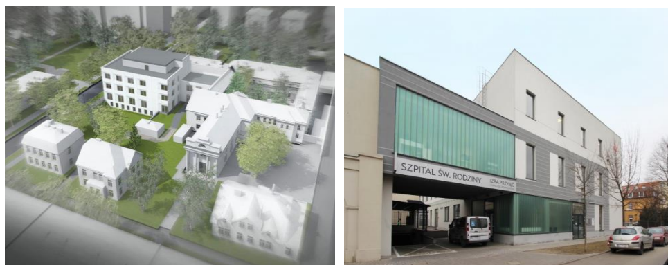
Rys. 1. Wizualizacja rozbudowy szpitala oraz zdjęcie oddanego do użytku budynku szpitala (archimed.pl)
