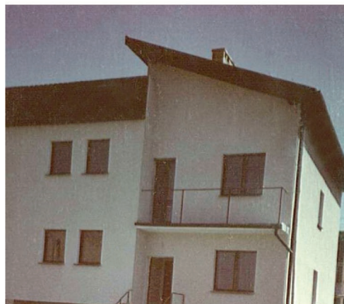
W trakcie budowy – przed posadzeniem roślinności
