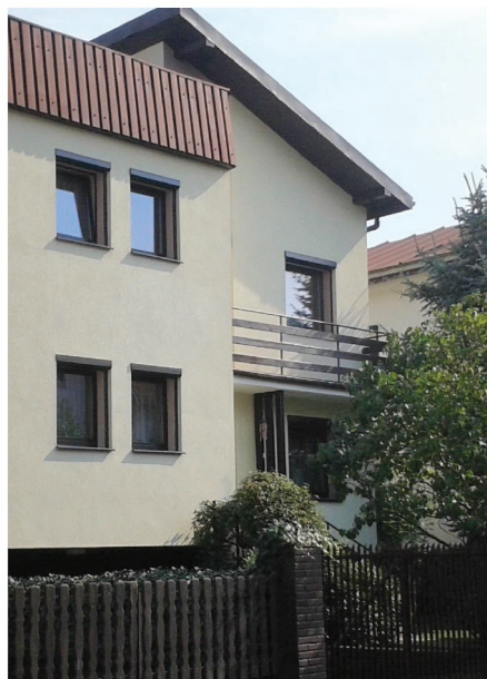
Ilustracja 5. Wygląd budynku po termomodernizacji (jesień 2014)
