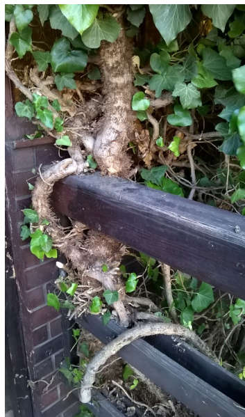
Ilustracje 1, 2. Roślinność degradująca strukturę budynku: bluszcz ( Hedera helix ) w przestrzeni między elementami drewnianej balustrady; bluszcz ( Hedera helix ) przy szybie werandy Źródło: fot. J. Suchanek.
