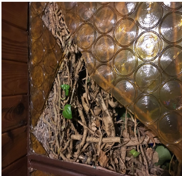
Ilustracje 1, 2. Roślinność degradująca strukturę budynku: bluszcz ( Hedera helix ) w przestrzeni między elementami drewnianej balustrady; bluszcz ( Hedera helix ) przy szybie werandy Źródło: fot. J. Suchanek.
