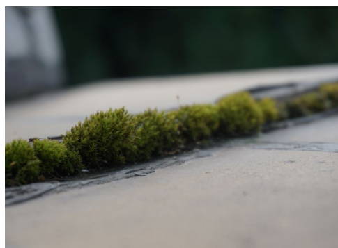
Ilustracje 3, 4. Roślinność degradująca strukturę budynku: mech w spoinie między płytkami posadzki tarasu; mech w podkładzie betonowym posadzki tarasu Źródło: fot. J. Suchanek.
