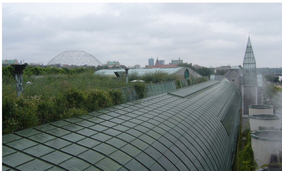
Ilustracja 4. Dach Biblioteki Uniwersytetu Warszawskiego, ul. Dobra 56/66, Warszawa (maj 2011) Źródło: fot A. Kasińska-Andruszkiewicz.
