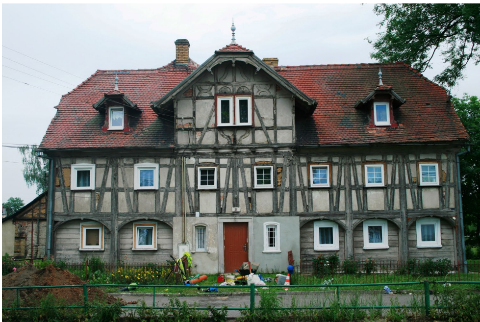
Rys. 6. Fasada domu przy ul. Nadbrzeżnej 18 (dawny dom ludowy) z doskonale widoczną strukturą konstrukcyjną ścian długosłupową, krótkomiczową (z knagami) i nadmierną w stosunku do potrzeb konstrukcyjnych liczbą zastrzałów pełniących funkcje bardziej dekoracyjne niż strukturalne. W wystawie zastosowano dekoracje drewniane w tzw. stylu szwajcarskim – bogata forma budynku uzasadniona jest jego funkcją publiczną, dokumentacja pomiarowa [9a]
