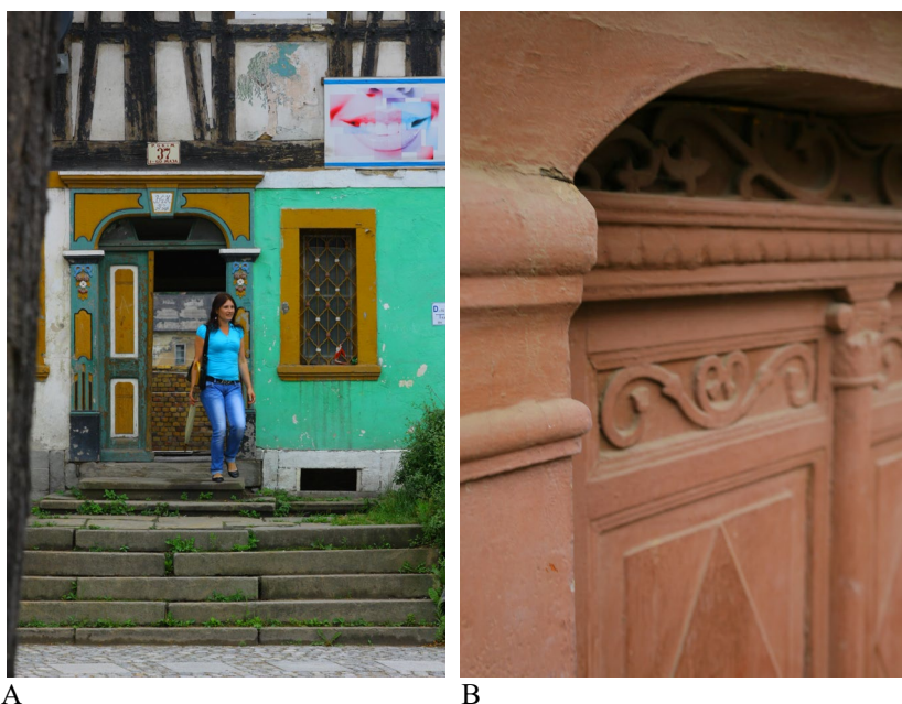
Rys. 15. Detal kamieniarski (A) oraz stolarka portali w fasadach (B) domów przysłupowych. Okna przy drzwiach frontowych zabezpieczone kutą kratą o typowej formie. Obserwowana obecnie tendencja pokrywania kamieniarki i ścian domów jaskrawymi kolorami [fot. M. Kozaczko]
