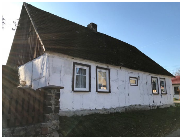
Rys. 4. Budynek szachulcowy nr 13 w Rakowie, elewacja frontowa z zamurowanym wejściem [fot. E. Angoneze-Grela, 2018]
