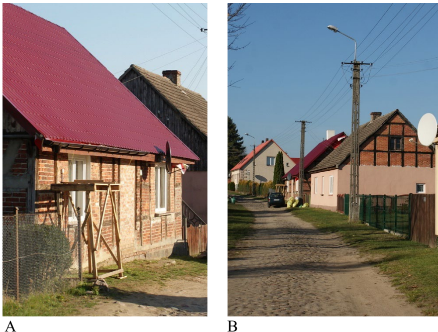
Rys. 3. Domy w drewnianej konstrukcji szkieletowej w Liszkowie, pow. szczecinecki, na zdjęciach widoczne zamurowane wejścia frontowe (A) i tynk częściowo przesłaniający charakterystyczną kratę (B) [fot. E. Angoneze-Grela, 2018]
