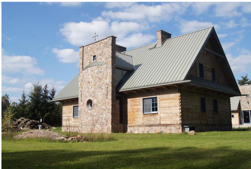
Rys. 25. Poletyły. Rzymskokatolicka pustelnia – kartuzja wiejska. Widok zewnętrzny domu-kaplicy Zwiastowania NMP od strony południowej. Autor architektury: Jerzy Uścińowicz, 2017 r. [zdj. J. Uścińowicz]
