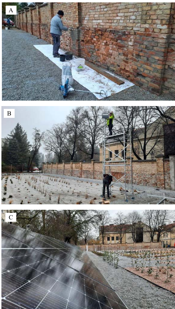
Rys. 10. Prace realizacyjne: renowacja muru od strony ul. Jana Lubrańskiego (A); montaż reflektorów zalewowych (B); ciąg ogniw fotowoltaicznych wzdłuż północnej granicy terenu produkujących energię do iluminacji założenia (C) [fot. 10A, 10B z archiwum Fundacji; fot. 10C Robert Woźniak]
