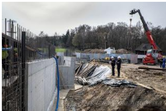
Rys. 19. Budowa kościoła na Woli Justowskiej – stan w kwietniu 2016 r. [ze zbiorów parafii]
