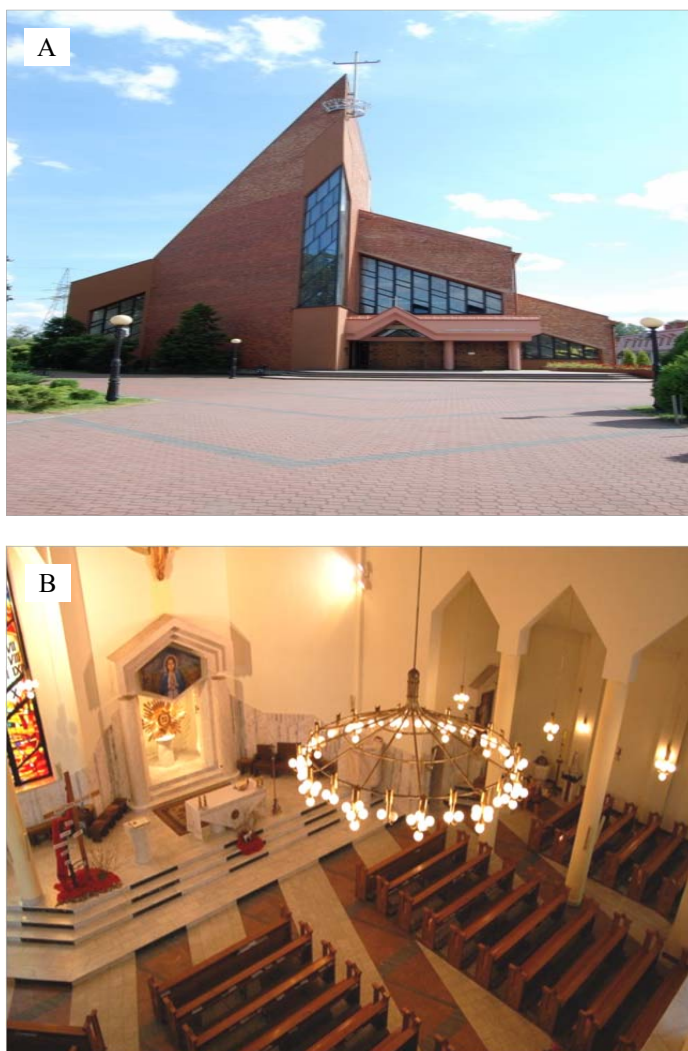
Rys. 6. Kościół Narodzenia NMP w Myszkowie: elewacja frontowa (A); wnętrze kościoła (B) [fot. autorki]
