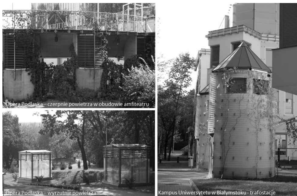
Rys. 3. Zewnętrzne elementy techniczne jako mała architektura [fot. K. Ilmurzyńska]
