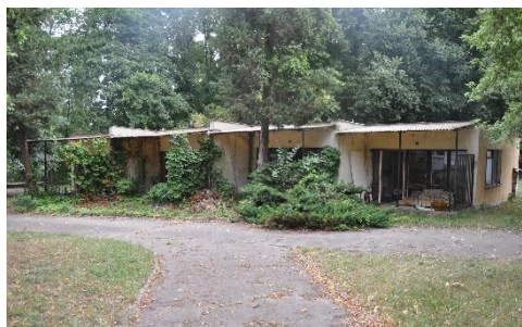
Rys. 7. Kiekrz, ośrodek wybudowany dla Akademii Rolniczej w Poznaniu zlokalizowany nad Jeziorem Kierskim, oryginalne domki szeregowe – stan przed remontem [fot. J. Bogajewska-Danek, 2021]
