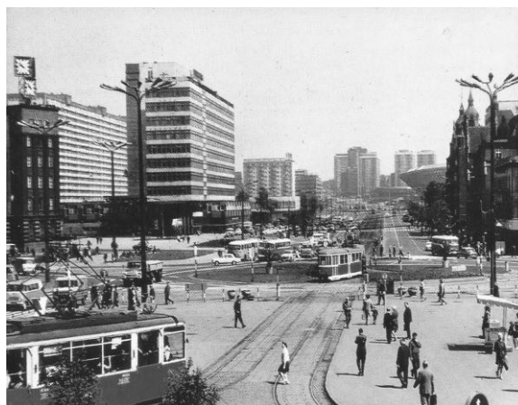
Rys. 17. Katowice, widok na układ komunikacyjny śródmieścia, fot. K. Kaczyński, 1969 [Phototrans 2022]
