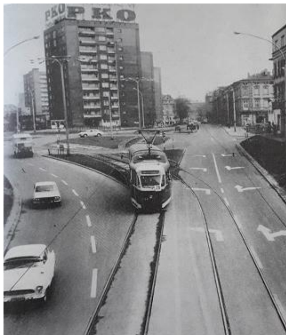
Rys. 5. Centrum Sosnowca w trakcie modernizacji [Kasprów, Knobelsdorf 1977]
