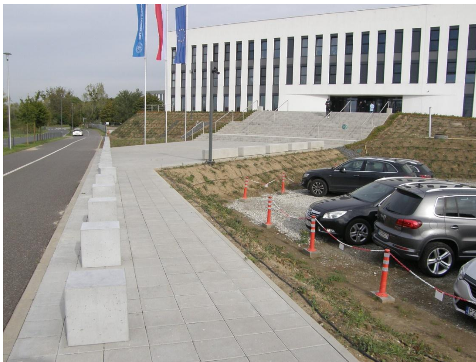
Rys. 1. Rytm betonowych kostek, widok na Wydział Architektury oraz Inżynierii Zarządzania, kampus Politechniki Poznańskiej [zdjęcie K. Grygorowicz-Kosakowska]
