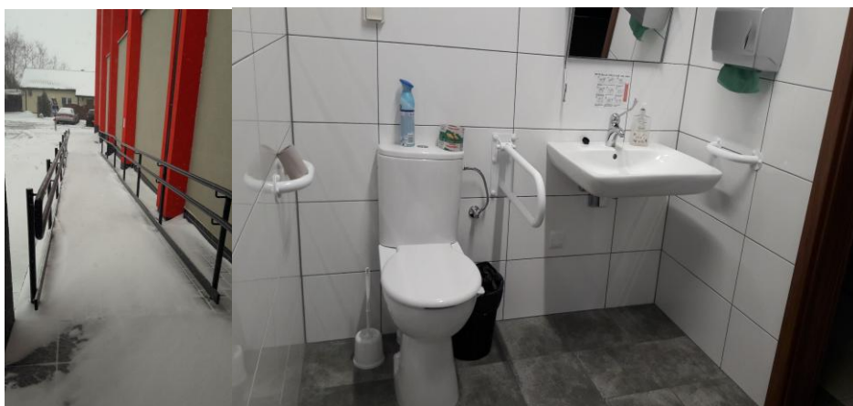
Rys. 1. Pochylnia zewnętrzna oraz toaleta dla osób z niepełnosprawnościami [fot. Matylda Rakowicz]
