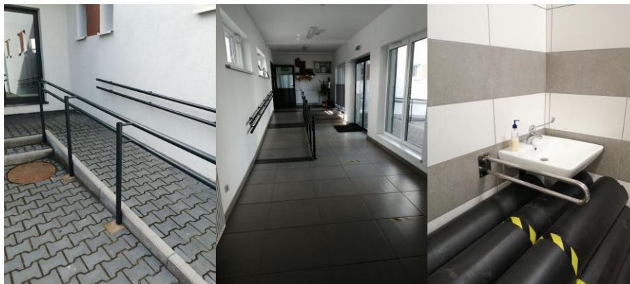
Rys. 6. Pochylnia zewnętrzna, pochylnia wewnętrzna oraz toaleta dla osób z niepełnosprawnościami [fot. M. Rakowicz]
