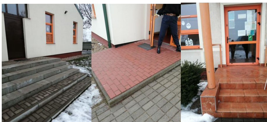
Rys. 3. Wejścia do budynku [fot. M. Rakowicz]
