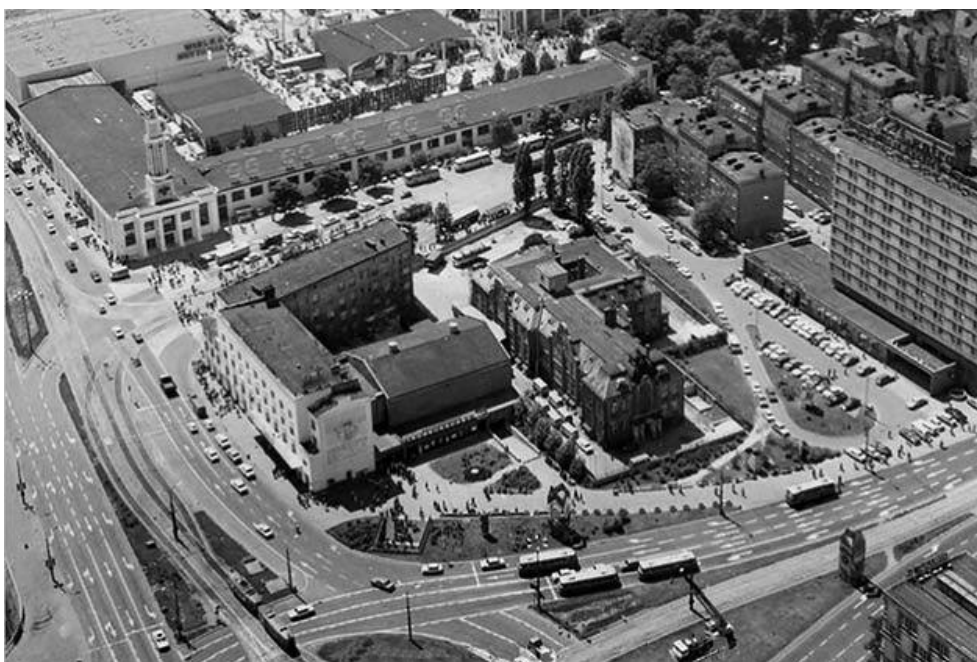
Rys. 4. Wnętrze kwartału z domem studenckim Jowita, proj. Witolda Milewicza i Zygmunta Skupniewicza, 1964 [Archiwum MTP]
