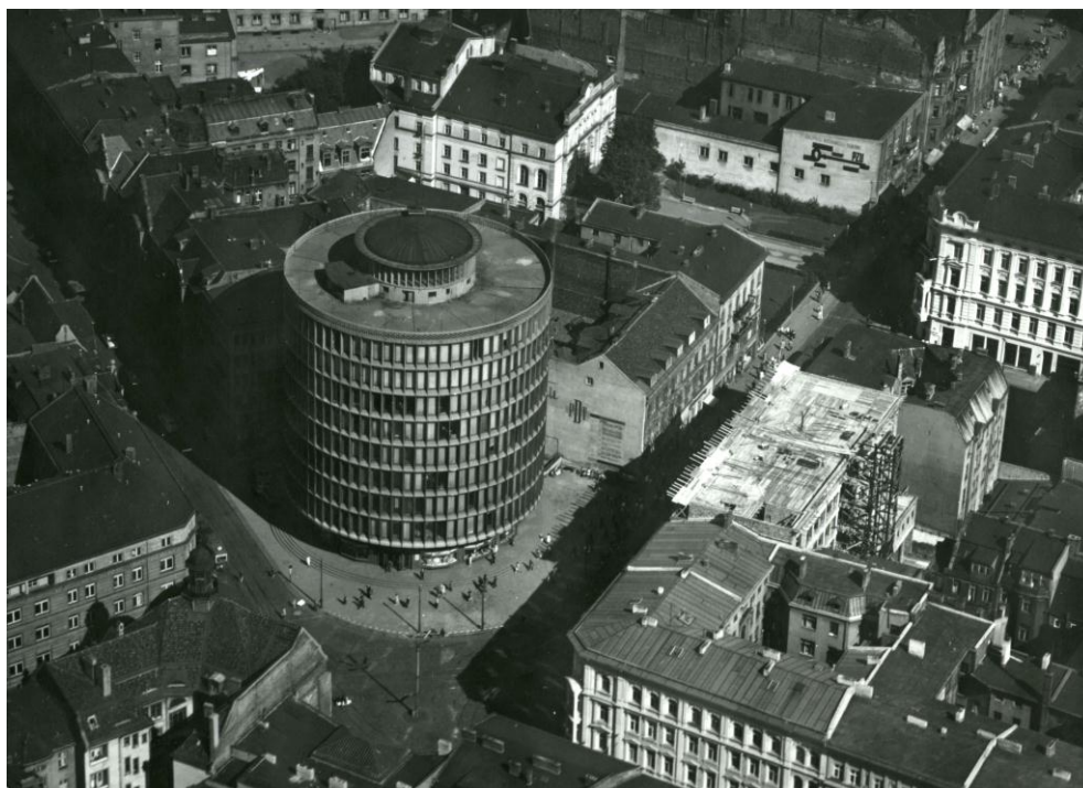
Rys. 13. Dom Towarowy Okrągłak z lotu ptaka, widoczna ślepa ściana kamienicy przy ul. 27 Grudnia i plac przed Teatrem Polskim [fot. Piotr Morszner, cyryl.poznan.pl]
