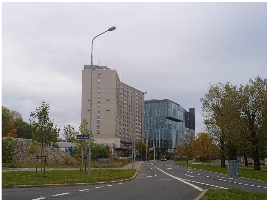
Rys. 7. Najnowsze inwestycje powstałe w ostatnich dziesięcioleciach w otoczeniu wzgórza Świętego Wojciecha. Na pierwszym planie hotel „Polonez”, w głębi budynek Urzędu Marszałkowskiego [oprac. własne]
