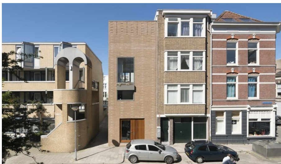
Rys. 3. Dom w Rotterdamie [Architectuurmaken 2022]
