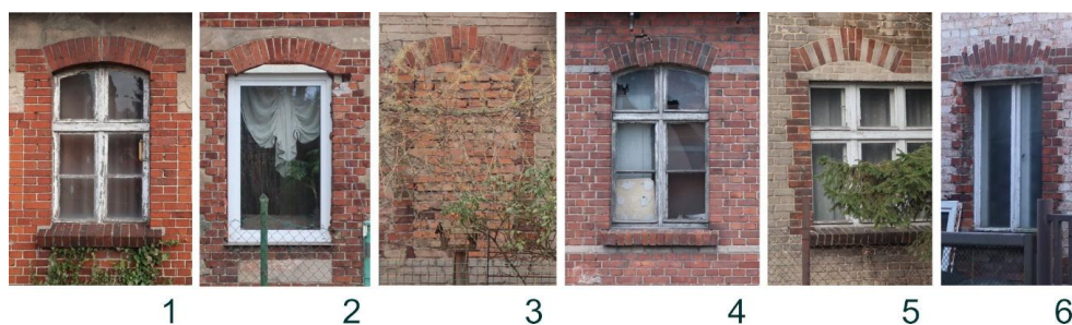
Rys. 6. Detal wiatku ceglanego i form ścian frontowych i szczytowej przykładowego budynku kolonii [fot. R. Graczyk]
