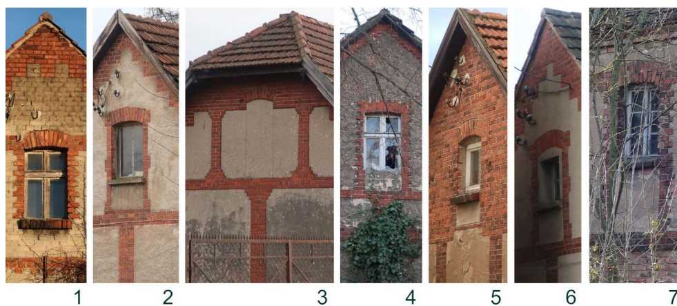
Rys. 5. Detal wiatku ceglanego i form ścian frontowych i szczytowej przykładowego budynku kolonii [fot. R. Graczyk]
