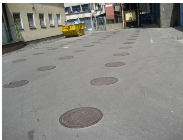
Rys. 3. Strop bunkra z widocznymi węglowymi włazami wyspowymi [oprac. własne]
