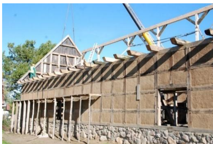
Rys. 3. Swołowo, odbudowa domu metodą tradycyjną [Muzeum Swołowo]
