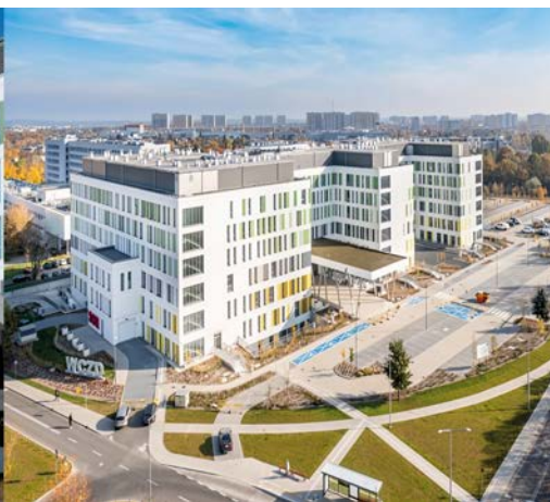
Rys. 20. Budynek z perspektywy ptaka [Szpitale Wielkopolski 2025]
